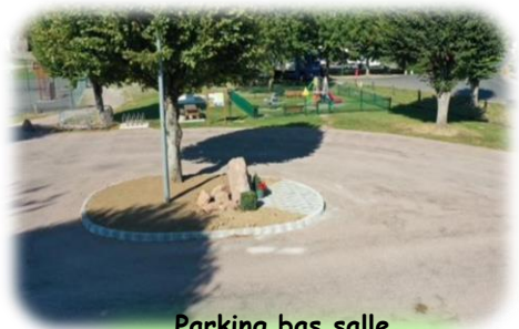
Parking bas salle A. Godier +stèle Bicouche, pose de bordures et réfection de la stèle 25 491,60 € TTC
